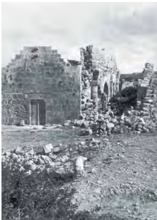
1. Δυτική άποψη της βασιλικής της Παναγίας Αφέντρικας. (φωτ. Τμήμα Αρχαιοτήτων).
