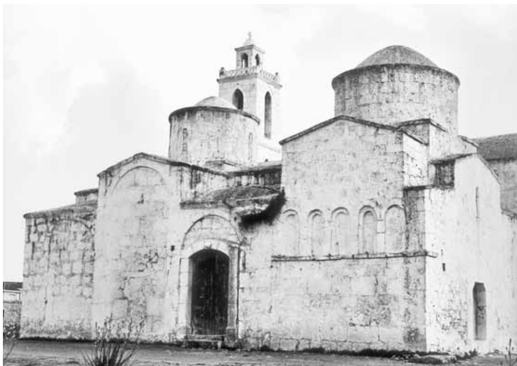
2. Βορειοδυτική άποψη του ναού του Αρχαγγέλου στη Γαλούσα. (φωτ. Τμήμα Αρχαιοτήτων).
