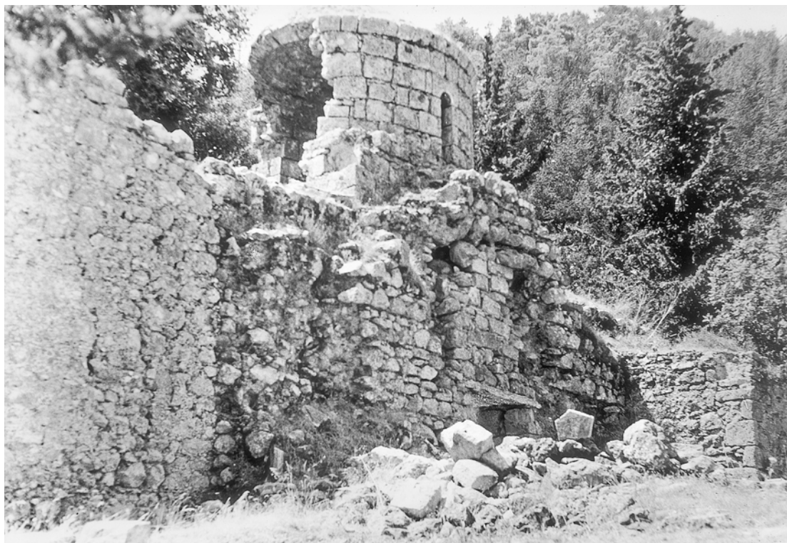
1. Η βόρεια όψη του ναού της Παναγίας Κρινιώτισσας πριν από την επισκευή του 1967. (φωτ. Α. Παπαγεωργίου).
