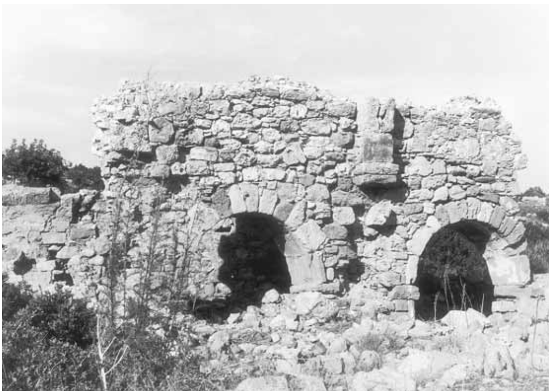
2. Το σωζόμενο τμήμα της βόρειας τοξοστοιχίας της βασιλικής της Αγίας Βαρβάρας. (φωτ. Α. Παπαγεωργίου).
