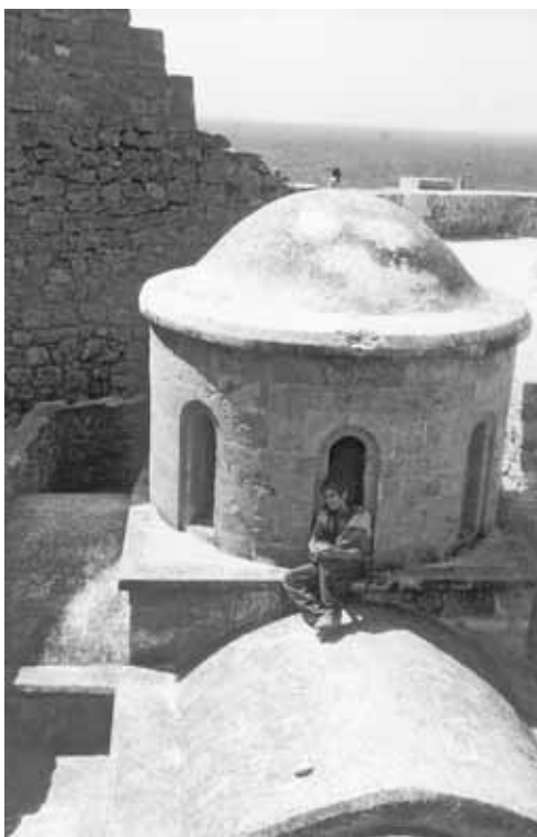
2. Ο αναστηλωμένος τρούλλος του ναού του Αγ. Γεωργίου του κάστρου της Κερύνειας. (φωτ. Τμήμα Αρχαιοτήτων).
