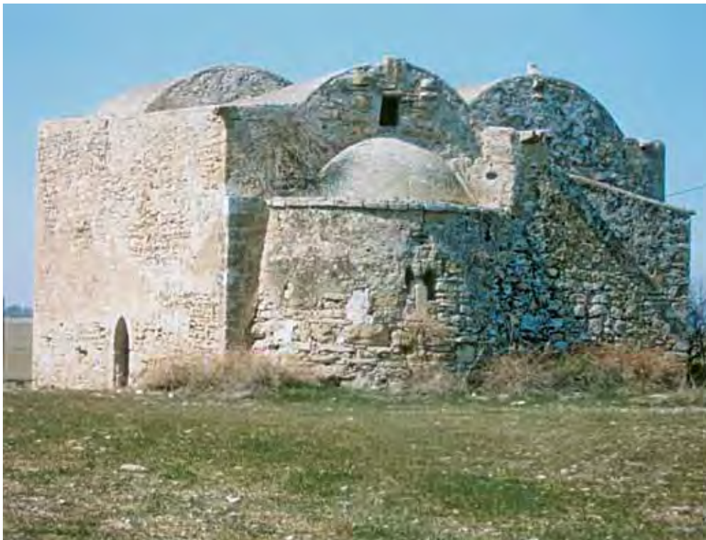
1. Ο ναός του Αγ. Γεωργίου(;) στο Ορνίθι από τα νοτιοανατολικά. (φωτ. Τμήμα Αρχαιοτήτων).
