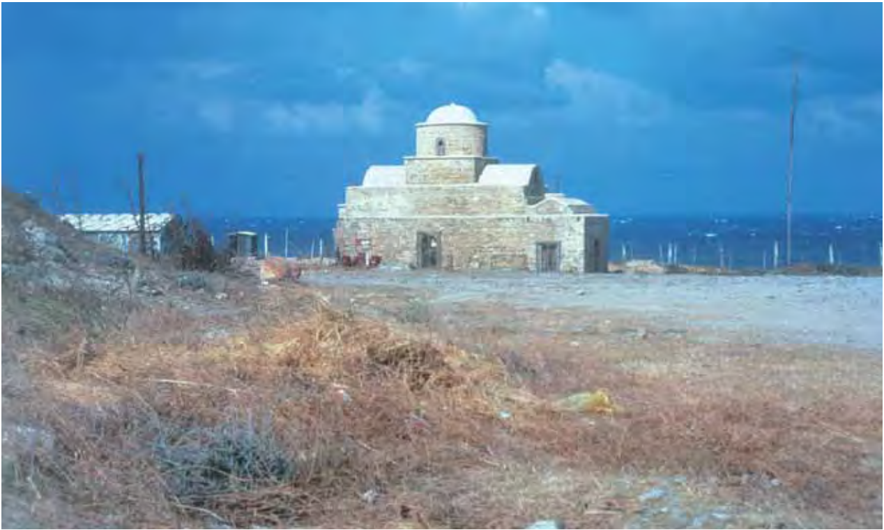
1. Βορειοδυτική όψη του ναού του Αγίου Ευλαλίου. (φωτ. Τμήμα Αρχαιοτήτων).
