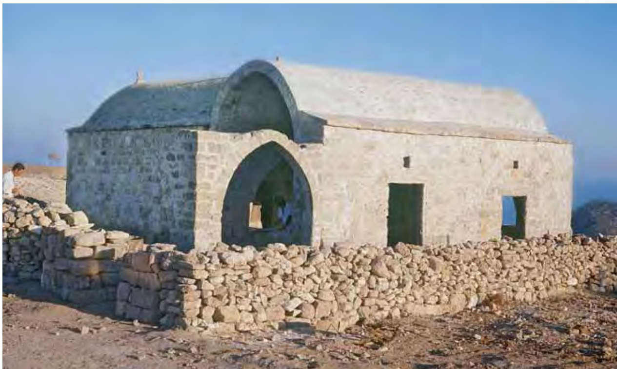
1. Βορειοδυτική άποψη του ναού του Αγ. Φίλωνος των Αγριδιών. (φωτ. Τμήμα Αρχαιοτήτων).
