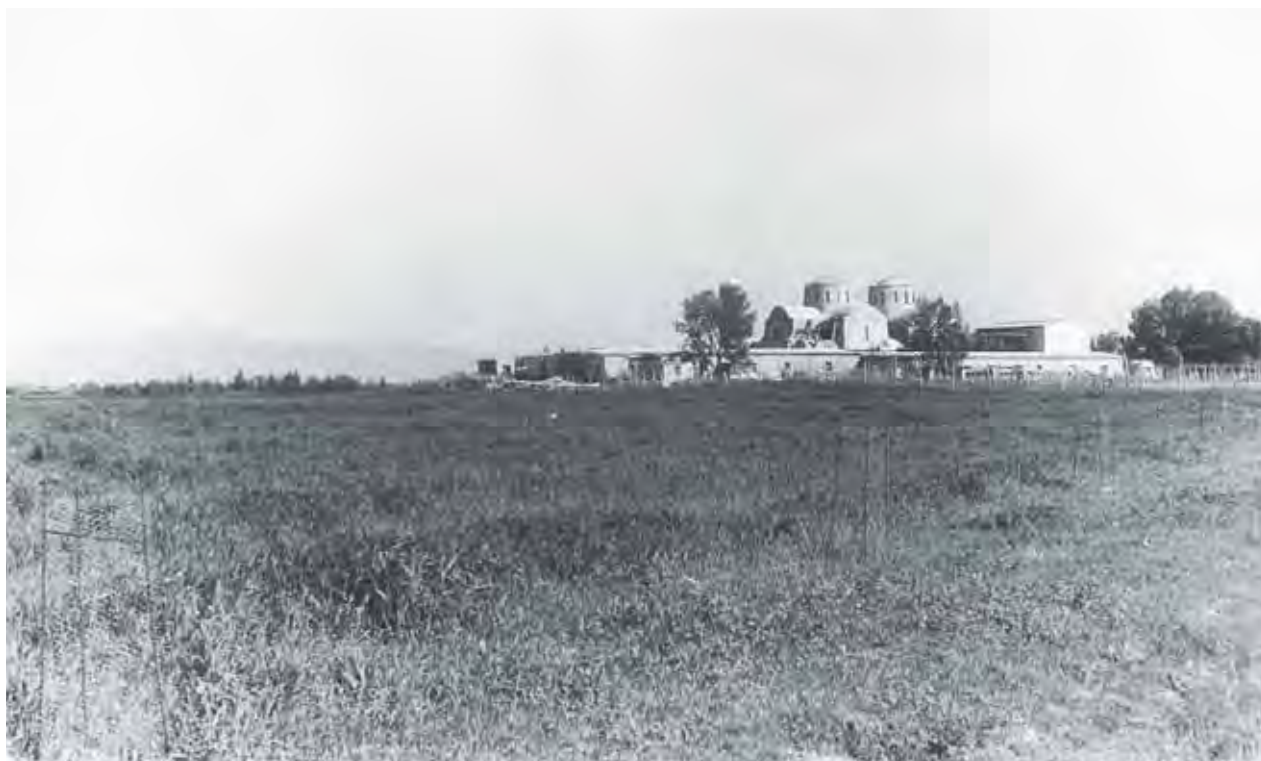
2. Γενική άποψη της Μονής του Αποστόλου Βαρνάβα από τα νοτιοδυτικά. (φωτ. Τμήμα Αρχαιοτήτων).
