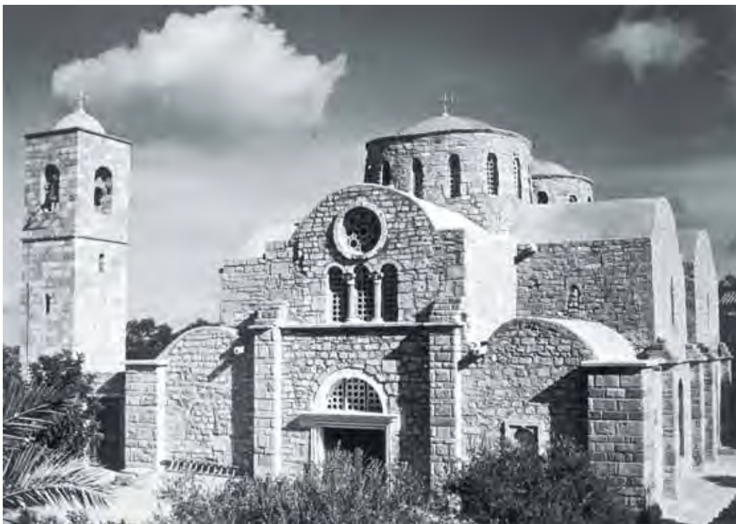
1. Δυτική όψη του ναού του Απ. Βαρνάβα. (φωτ. Τμήμα Αρχαιοτήτων).
