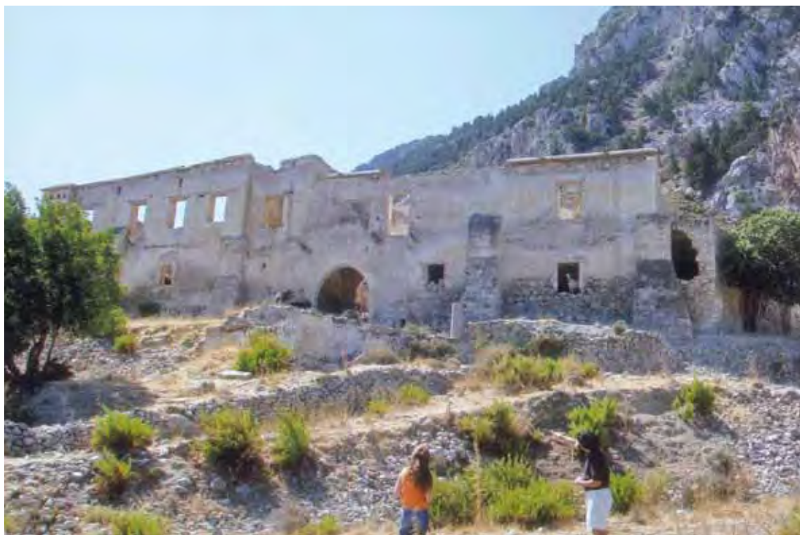
2. Γενική άποψη της Μονής της Αγίας Παρασκευής μετά το 1974. (φωτ. Αρχείο Ι. Συνόδου).
