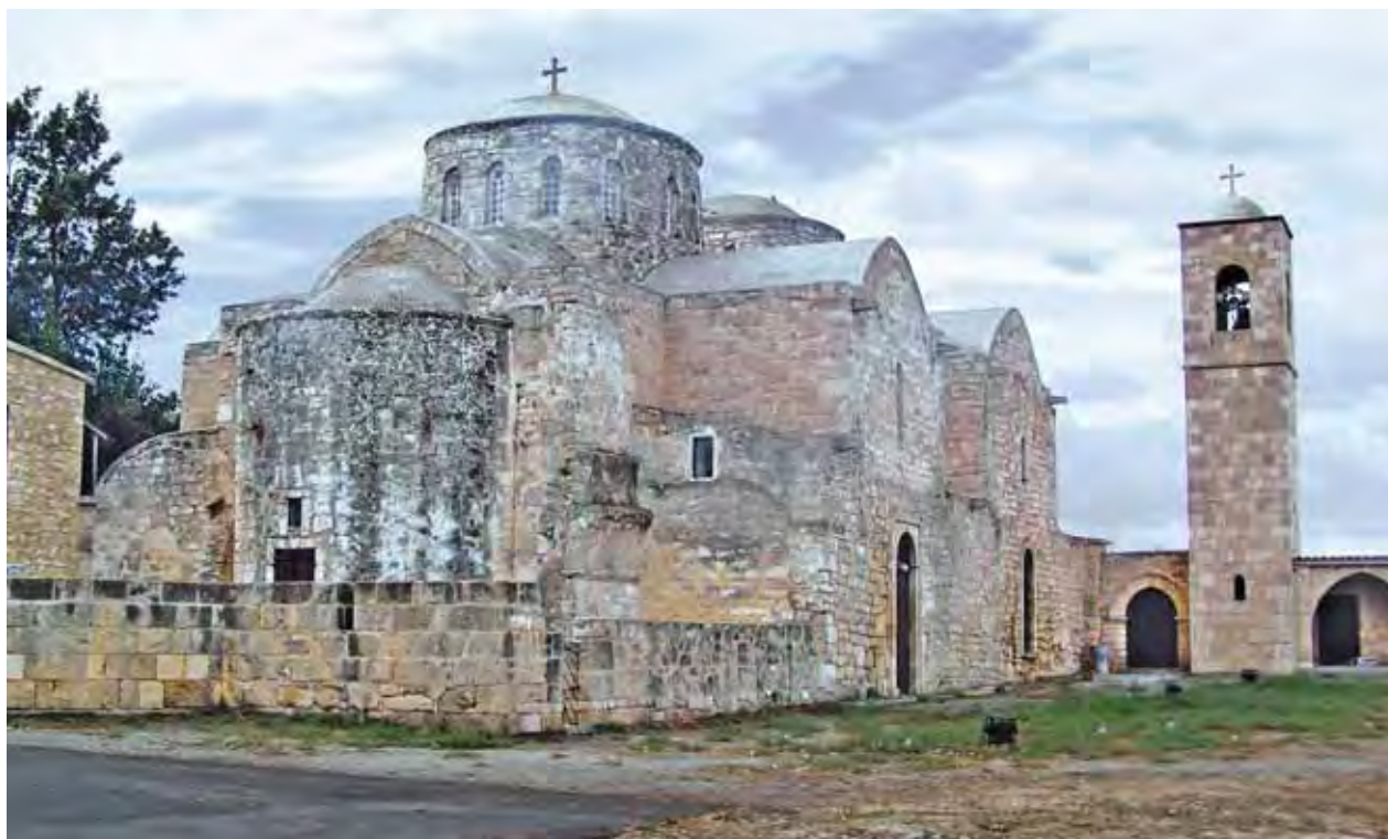
2. Ανατολική όψη του ναού του Απ. Βαρνάβα. (φωτ. Α. Φούλιας).
