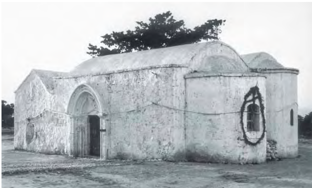
2. Νοτιοανατολική άποψη του ναού της Παναγίας Ελεούσας. (φωτ. Τμήμα Αρχαιοτήτων).
