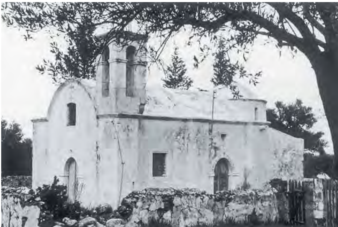
1. Νοτιοδυτική άποψη του ναού της Παναγίας Θερμιώτισσας πριν από το 1974. (φωτ. Τμήμα Αρχαιοτήτων).
