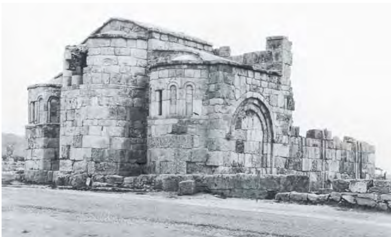
1. Βορειοανατολική άποψη του ναού του Αγίου Φίλωνος, (φωτ. Τμήμα Αρχαιοτήτων).
