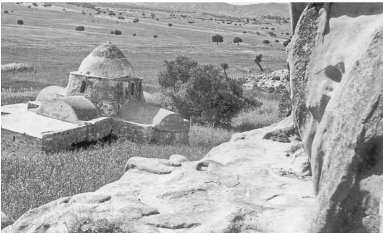
2. Νοτιοανατολική άποψη του ναού της Παναγίας Κυράς. (φωτ. Τμήμα Αρχαιοτήτων).
