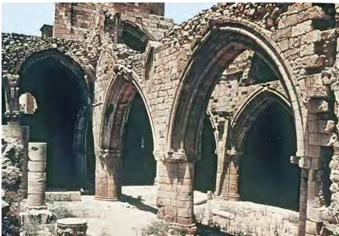
2. Μερική άποψη του εσωτερικού του ναού της Παναγίας Οδηγήτριας από τα δυτικά. (φωτ. Α. Παπαγεωργίου).
