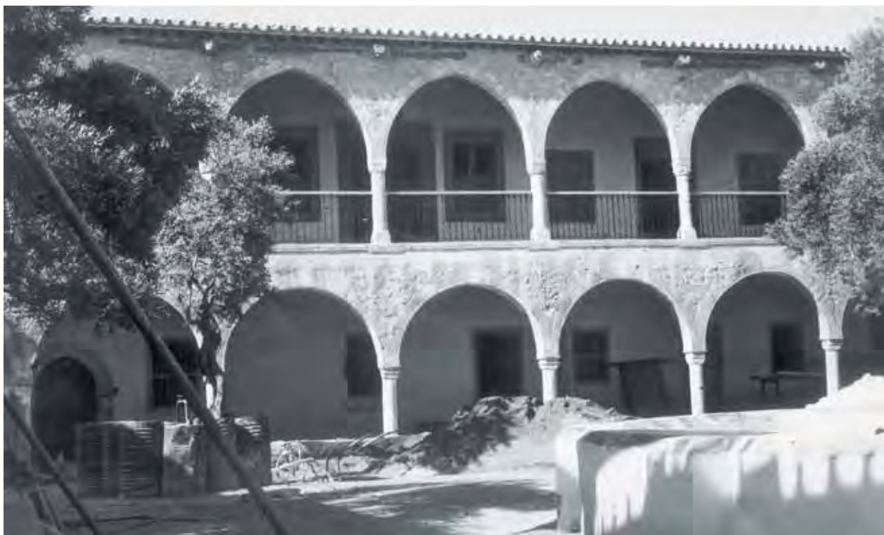
2. Λεπτομέρεια των μοναστηριακών κτιρίων κατά τη διάρκεια της επισκευής τους. (φωτ. Τμήμα Αρχαιοτήτων).
