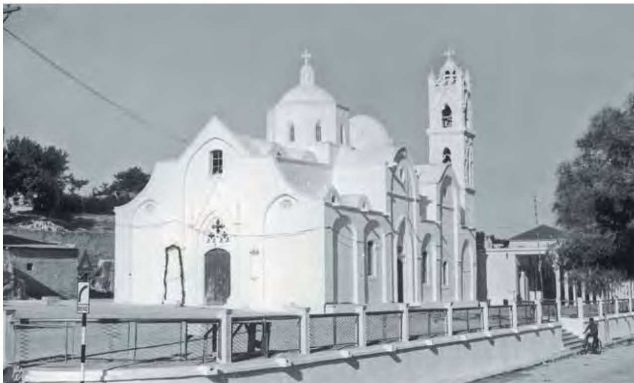
1. Νοτιοδυτική άποψη του ναού του Αγίου Συνεσίου. (φωτ. Τμήμα Αρχαιοτήτων).
