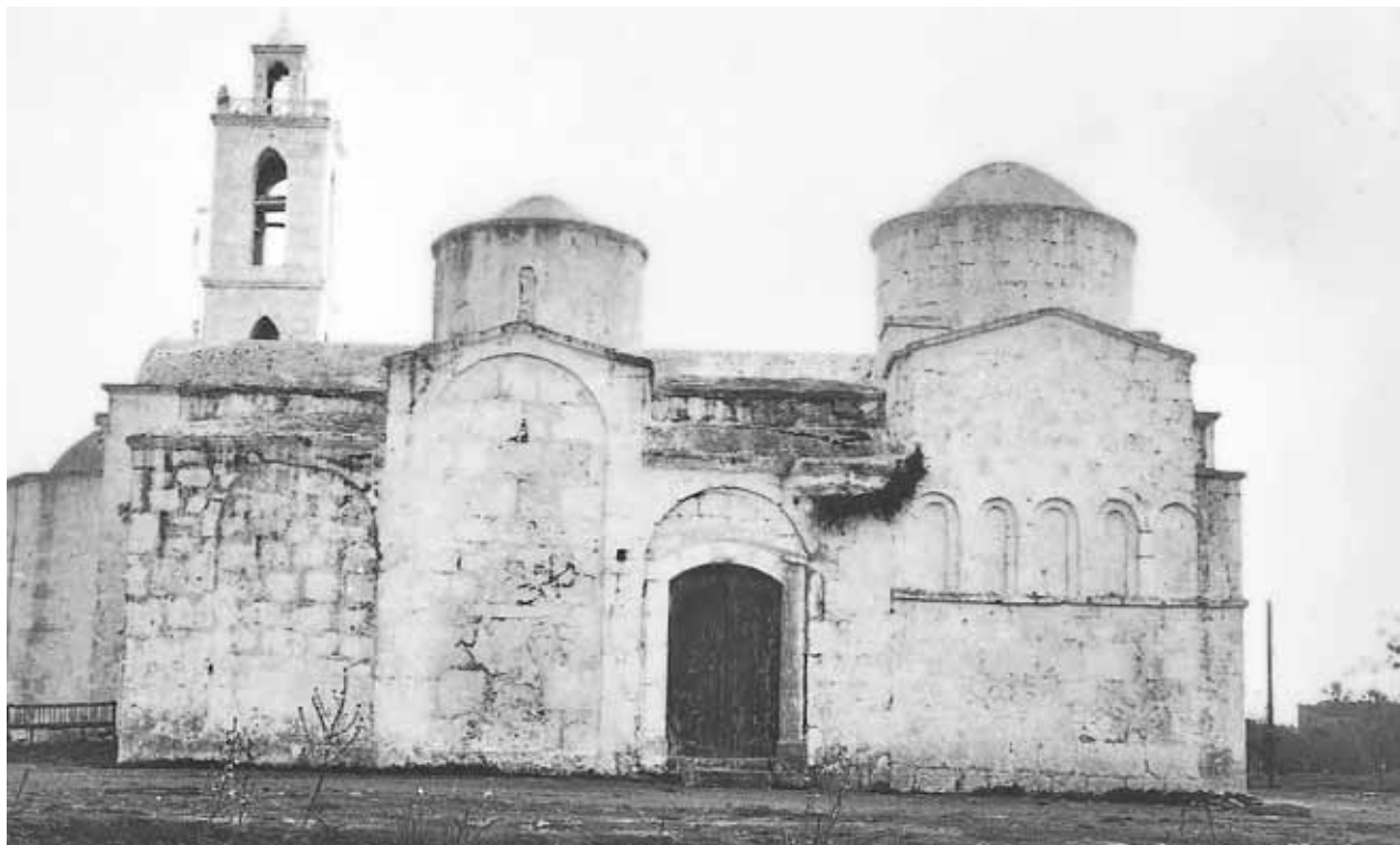
1. Βόρεια όψη του ναού του Αρχαγγέλου στη Γαλούσα. (φωτ. Τμήμα Αρχαιοτήτων).
