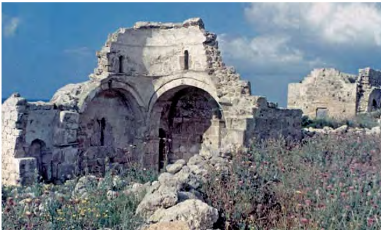
2. Νοτιοδυτική άποψη του ναού του Αγίου Γεωργίου Αφέντρικας. (φωτ. Α. Παπαγεωργίου).
